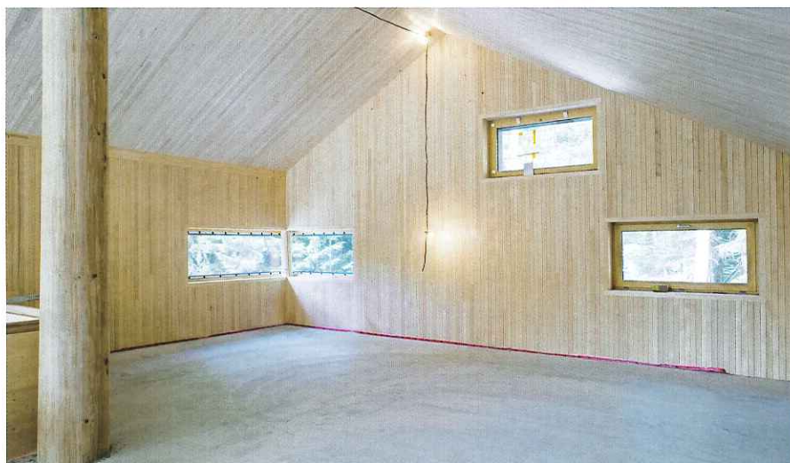
Das monolithische Erscheinungsbild setzt sich auch im Inneren des Gebäudes durch die sichtbar bleibenden Dübelholz-Elemente fort.
