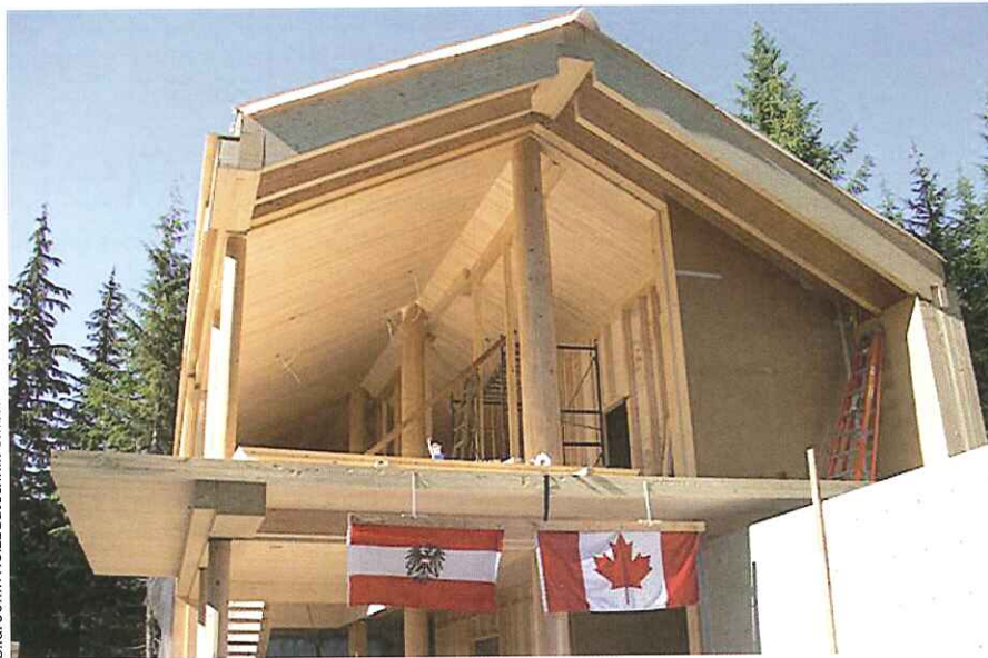
Das Primärtragwerk besteht aus Hauptträgern und Pfetten, die auf Rundholzstämmen aufliegen. Brettsperrholzelemente bilden die Decken und sorgen für die horizontale Aussteifung.
